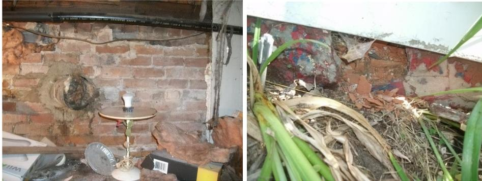
Comme il s'agit d'une fondation de maçonnerie, en bloc de béton **et/ou de pierre**, nous vous suggérons de faire une inspection périodique de celle-ci. Les risques d'infiltration d'eau sont plus importants sur ce type de fondation.
