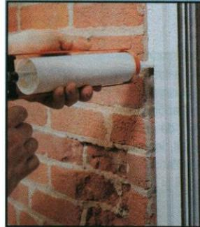
Faites avancer le pistolet à angle droit le long de la fissure ou du joint. La pâte doit adhérer aux deux côtés de la fente.
